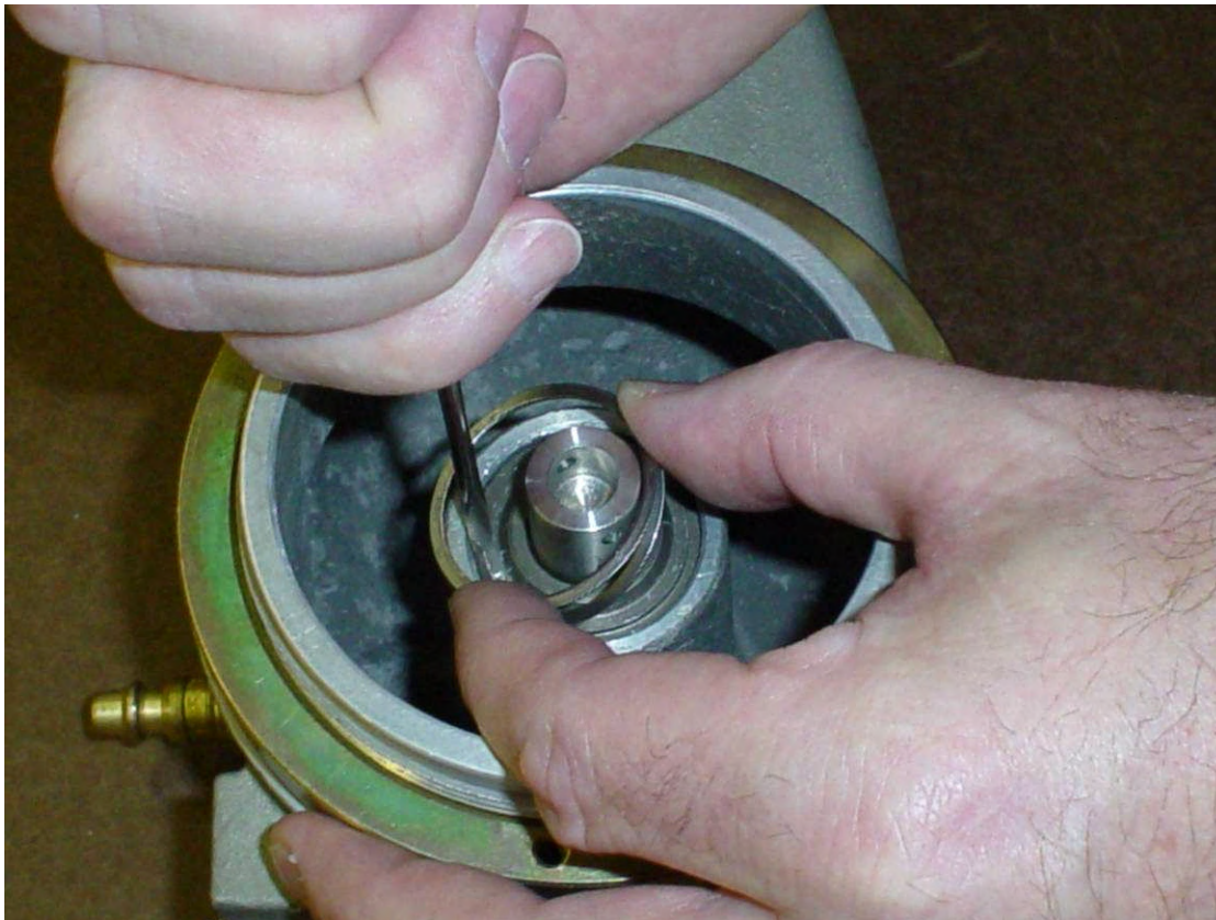
Figure 8 – installation de l’anneau de retenu
